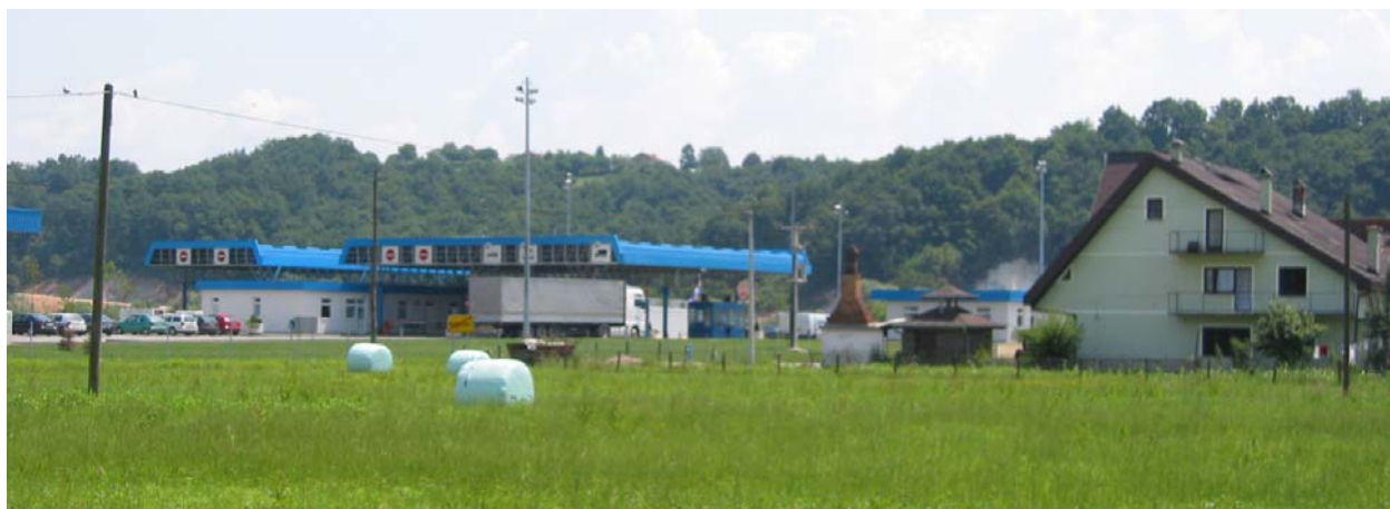
Slika 2. Granični prijelaz u Maljevcu
